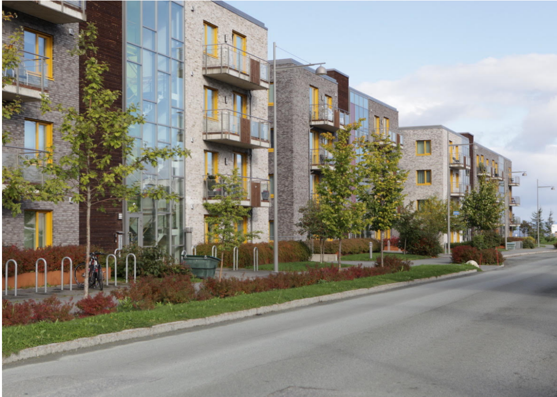
Arkitektur og landskapsarkitektur gir en boliggate karakter. Strindfjordvegen, Grilstad.
