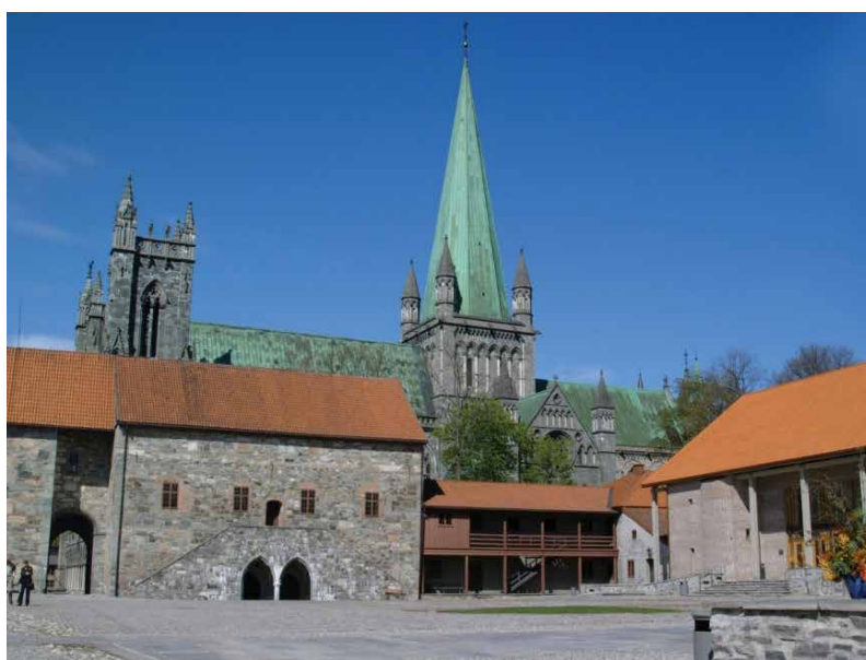
Bilde 4. Den nye delen av erkebispegården, til høyre på bildet, underordner seg og lar Nidarosdomen tre fram som det mest markante og karakteristiske både i gårdsrommet og i Nidelvas landskapsrom. Arkitekt: Nils Henrik Eggen arkitektkontor. Foto: Jørn Adde © Trondheim kommune
