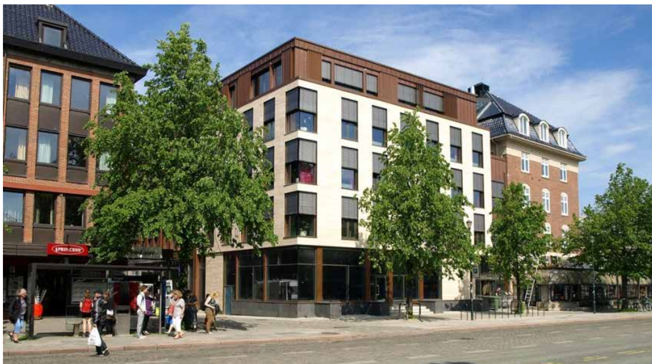
Bilde 13. Residencekvartalet. Eiendommen har stor synlighet fra Torvet, Trondheims viktigste byrom. Bygningen følger den historiske byggelinjen og utformingen bidrar til å skape en helhet i gatebildet. Arkitekt/foto: Svein Skibnes.
