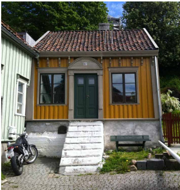
Bilde 16. Kokhuset er restaurert og tilbakeført til opprinnelig byggestil, av bygningsantikvar Mette Bye og arkitekt August J. Schmidt. Foto: Mette Bye.
